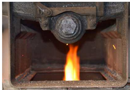
Abb.nr. 16 Nicht geeignete Flammenform
